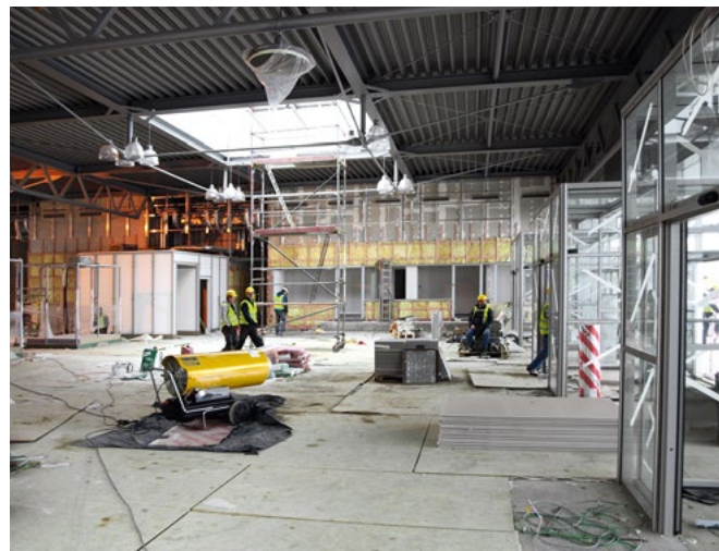
Le Master B 150 sur un chantier de construction
