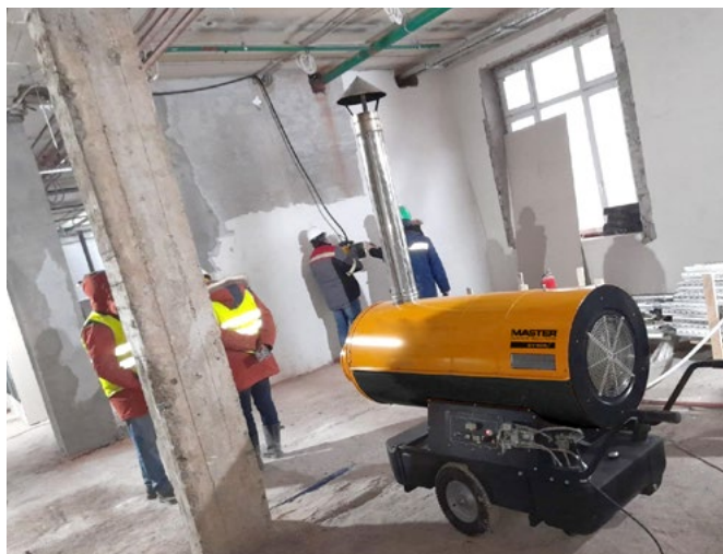
Le Master BV 400 sur un chantier de construction
