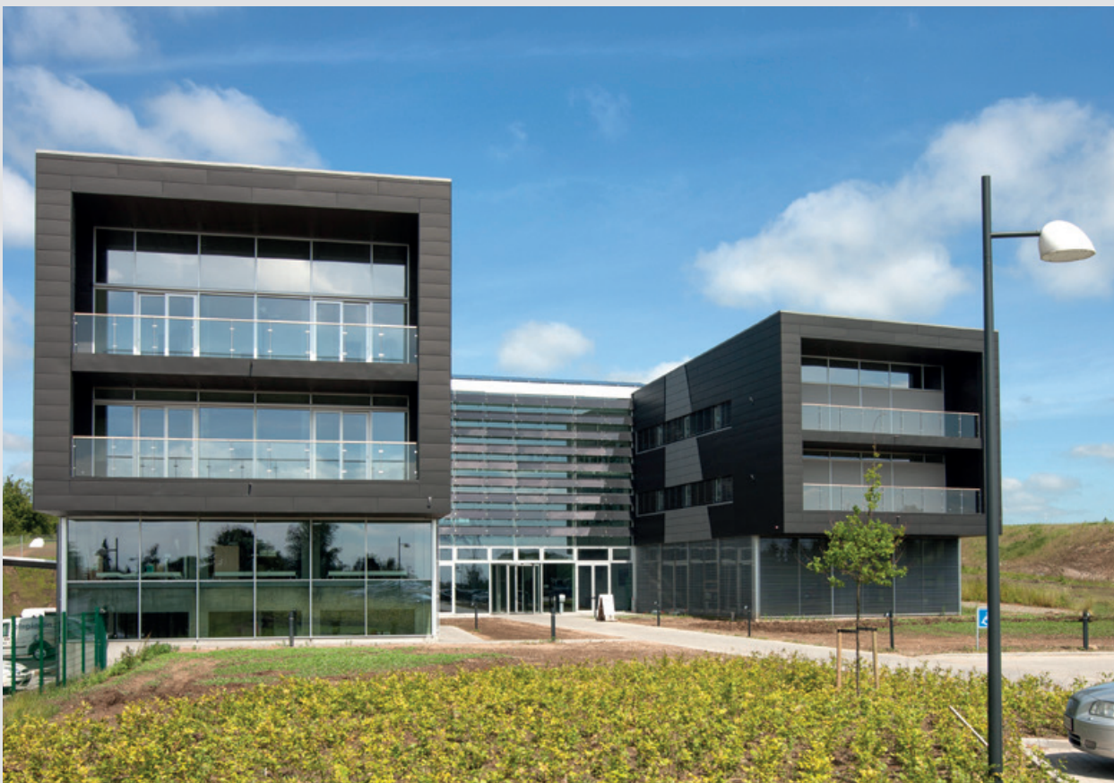
Exemple d'une solution en tertiaire Cascade de 5 NIBE F1345-60 pour le chauffage d'un immeuble de bureaux de 5 500 m 2
