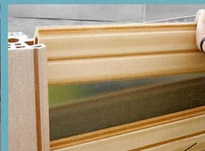
Le parement se compose des éléments composites. L'assemblage à rainure et languette est vraiment facile.
